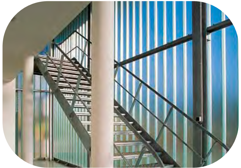
EDF Koblingsanlæg, Neuilly-sur-Marne, Frankrig. Pilkington Profilit ™
